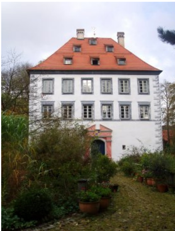
Das Wasserschloss Pilsach
