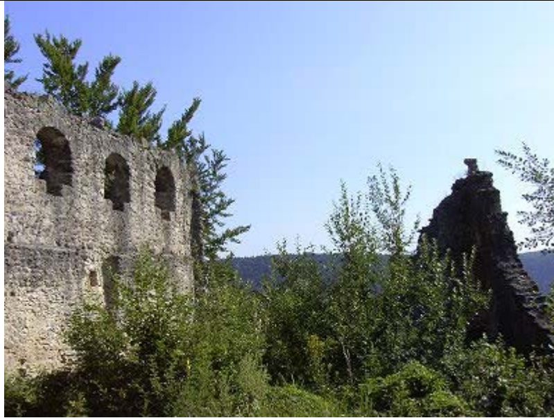
Von der Rumburg sind noch ein-drucksvolle Mauerreste erhalten
