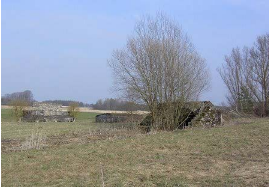
Brückenpfeiler und Durchlass Pyras
