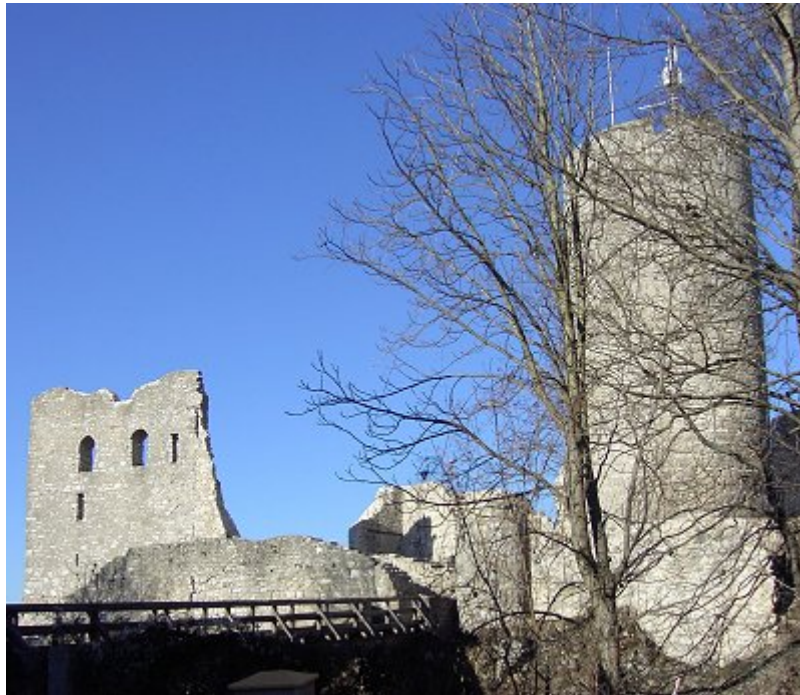
Eine Brücke überspannt den Burggraben der Ruine Wolfstein; rechts der Bergfried, links das Wohngebäude
